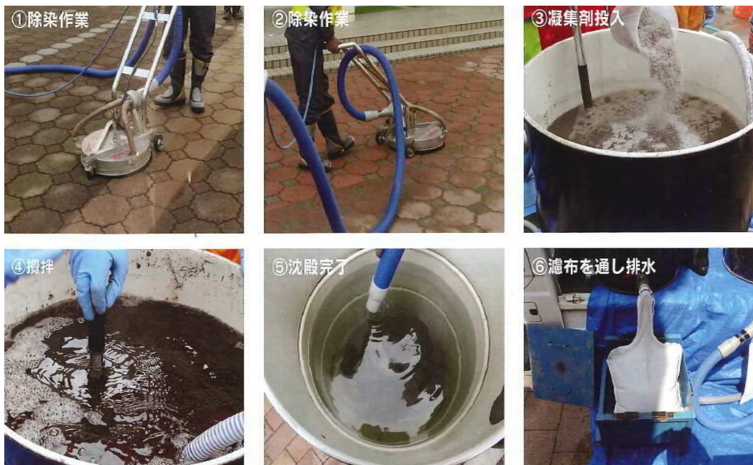
污水処理事例
