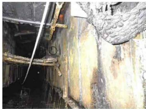
桁の被災状況
