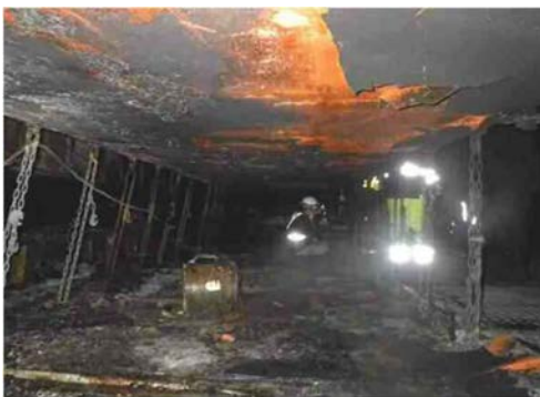
塗膜の被災状況
