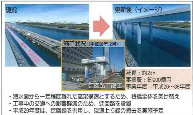
<更新の事例:首都高速 東品川栈橋・鮫洲埋立部>
