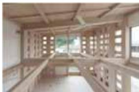
高倍率格子壁、合成梁を利用した吹抜け
