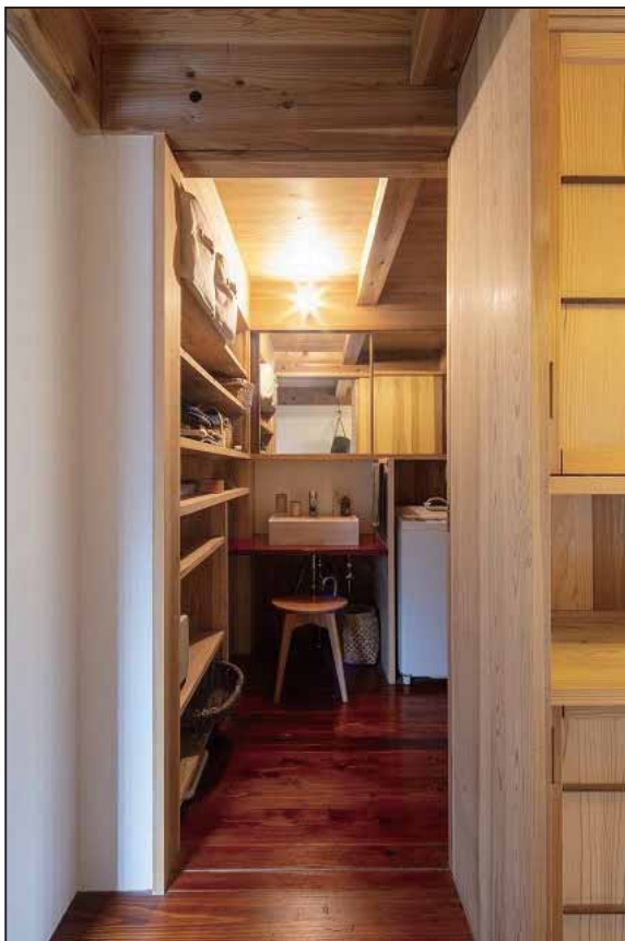
洗面台は漆溜塗（塗り/久津輪円さん） 浴室のサワラ板の漆塗りはワークショップで
